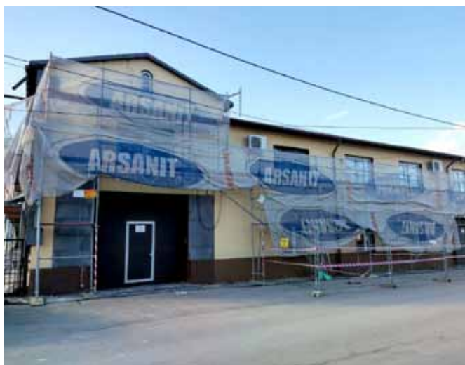
Termomodernizacja budynku OSP w Bestwinie
