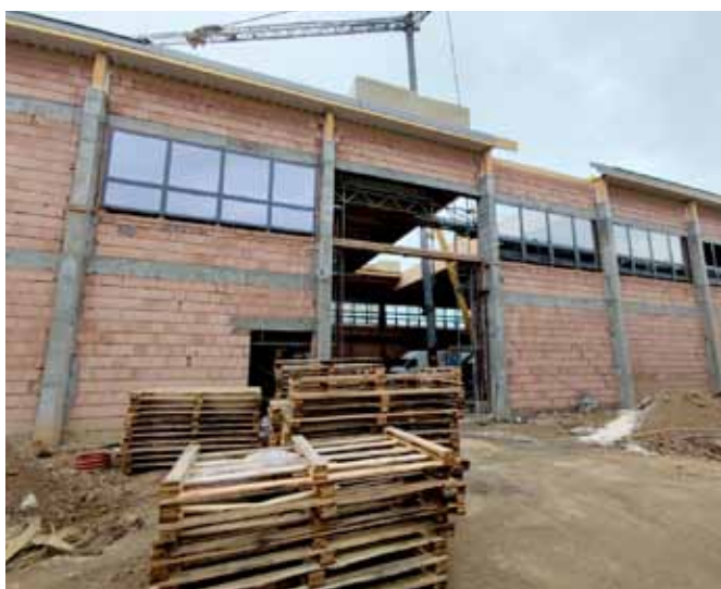
Budowa sali sportowej w Janowicach
